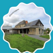
Maison du Parc naturel régional des Marais du Co- tentin et du Bessin
